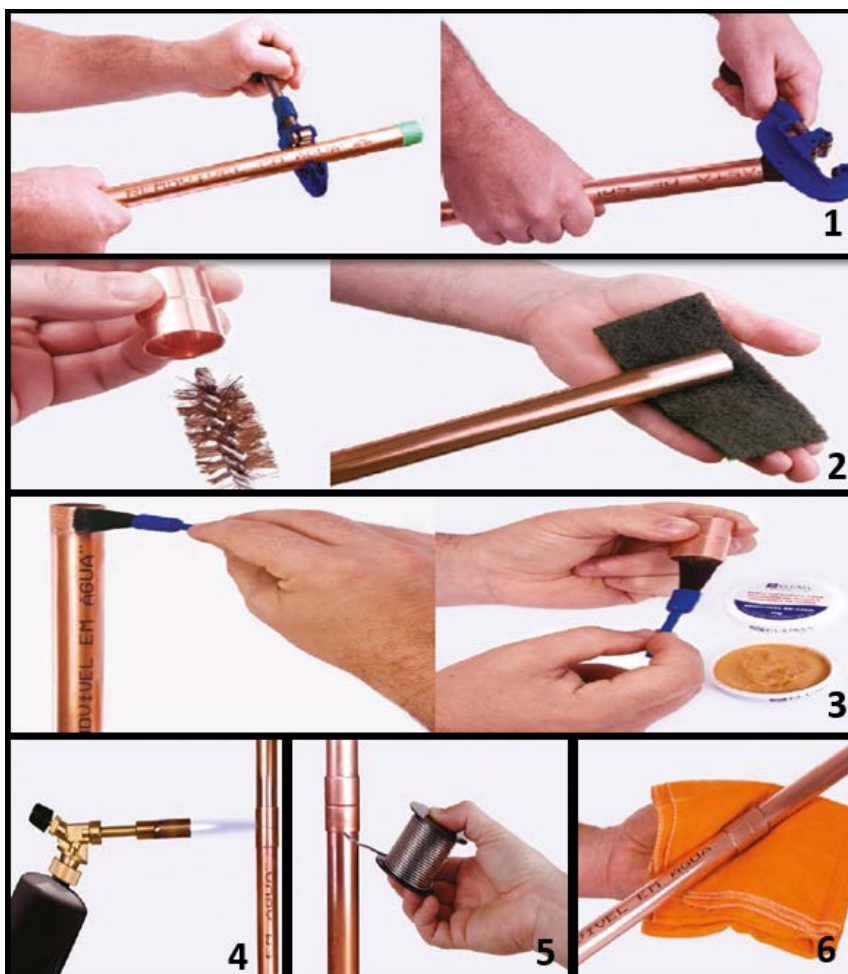
Figura 5 – Processo de instalação do cobre
