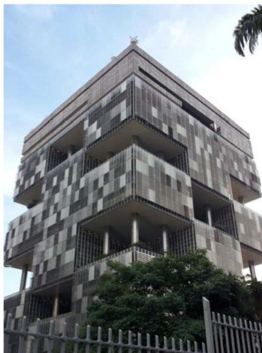
Figura 1 - Edificação em estudo
