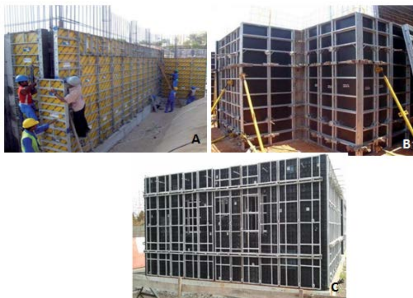
Figura 2 – Exemplo das formas estudadas. (A) Formas de alumínio; (B) formas de compensado; (C) Formas de plástico.
