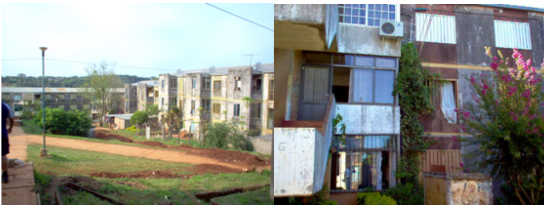
Figura 4: Espacios Fachada principal de una de las viviendas auditadas para este trabajo del Barrio M. Krause, Oberá, Misiones, Argentina (10/08/05). Obsérvese la tendencia a ejecutar cerramientos en el porche de ingreso.
