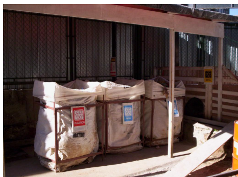
Figura 3 – Suporte com bags no térreo ao lado da baia de sucata metálica
