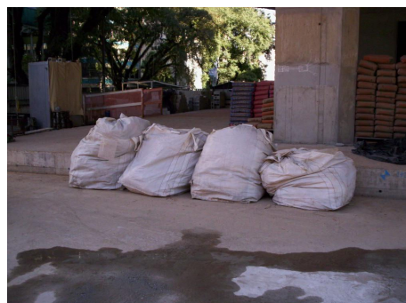
Figura 4 – Bags servindo como acondicionamento final dos resíduos
