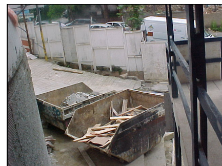
Figura 10 – Caçambas específicas para resíduos de madeira e concreto
