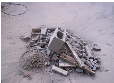
Figura 5 – Resíduos ainda misturados no pavimento aguardando segregação
