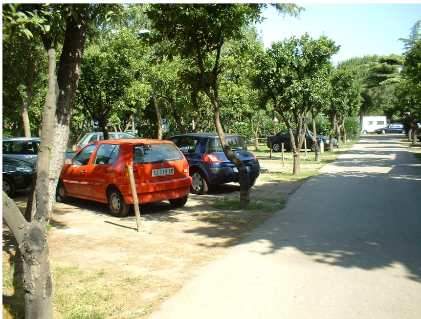
Figura 7. Bolsão de estacionamento no sítio arqueológico de Pompéia-Itália, com mescla de piso impermeável, na área destinada à circulação de veículos e área gramada, no local de estacionamento (Foto: Ricardo Moretti).
