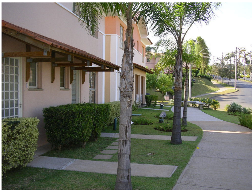
Figura 6. Passeio de pedestres na Villa Flora, Sumaré-SP, que mescla área permeável com área impermeável, possibilitando boa infiltração das águas pluviais no solo. (Foto: Ricardo Moretti)
