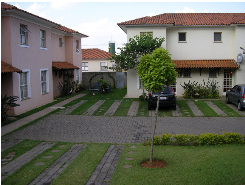
Figura 8. Estacionamento para veículos leves, dentro de condomínio horizontal, em Villa Flora, Sumaré-SP. (Foto: Ricardo Moretti)
