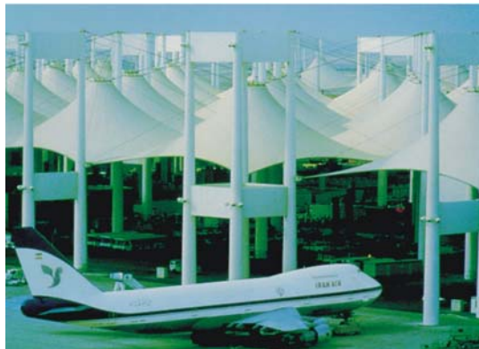
Figura 1 - Aeroporto Haj Terminal em Jeddah, Arábia Saudita, 1982 (ASCE, 1996).
