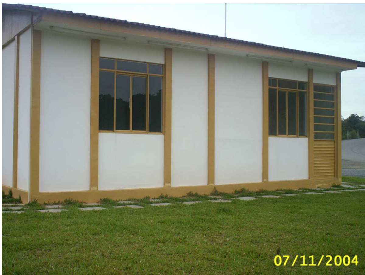
Figura 1 – Protótipo de habitação popular existente, na Rua Tamoios nº. 96, Salto do Norte, Blumenau.
