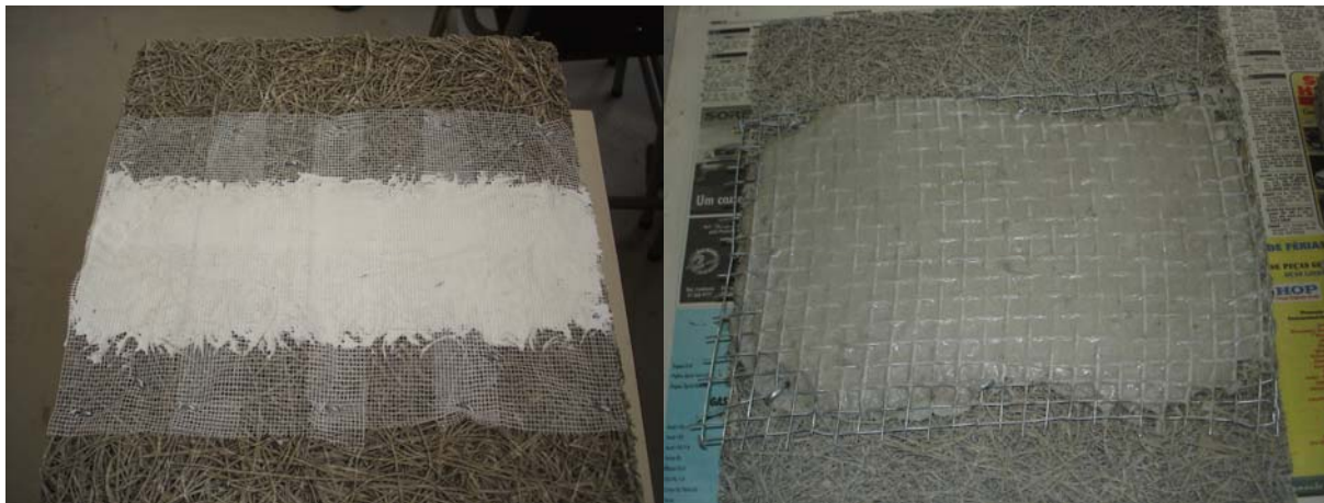
Figura 2 – Tela plástica com cola plástica (esq.); tela metálica com argamassa colante (dir.).
