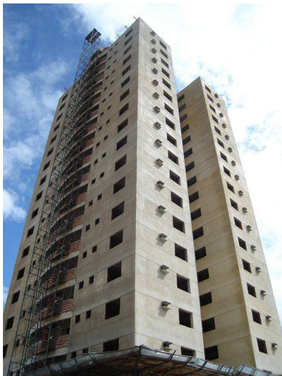
Figura 1: Edificação onde foram realizadas as medições de umidade.
