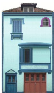
Figura 3 – Edifício 1: edifício com desordem histórico
