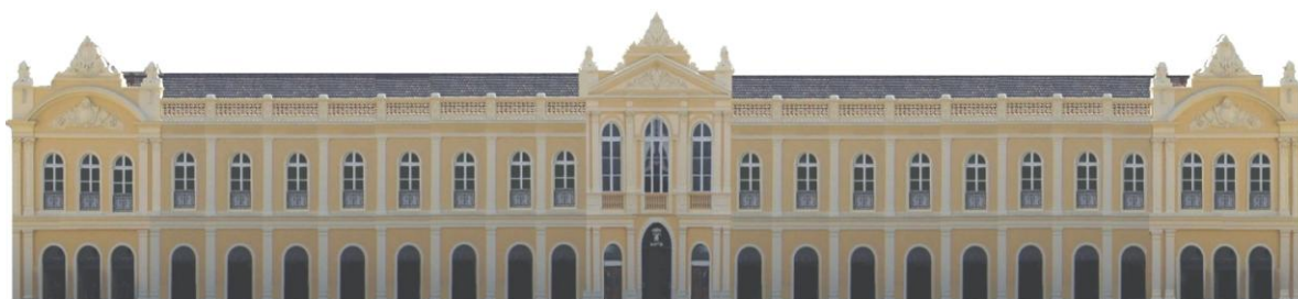
Figura 5 – Edifício 3: edifício com ordem e estímulo histórico
