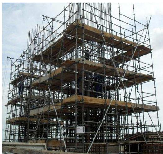
**Foto 2:** Colocação dos chumbadores do primeiro nível do pilar C8.
