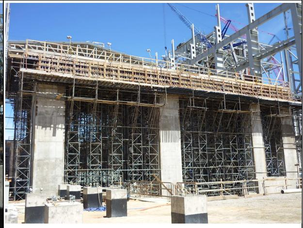
**Foto 6:** Vista geral da turbina com cimbramento da laje concluído.
