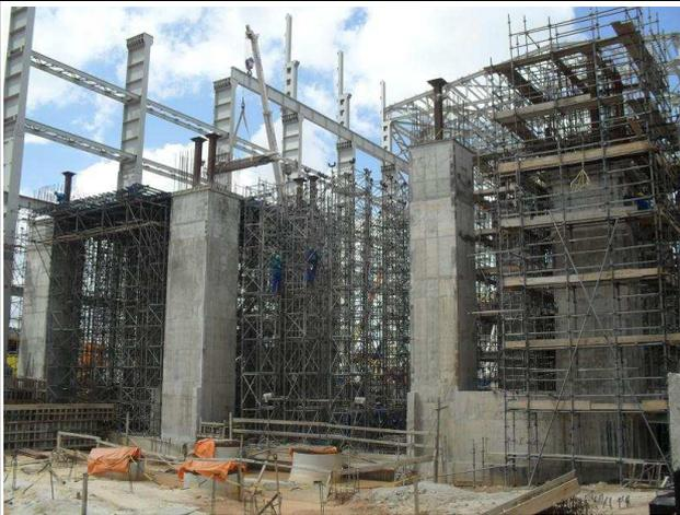
**Foto 5:** Montagem cimbramento da laje até 2º trecho e início da forma de fundo da laje no 1º trecho.
