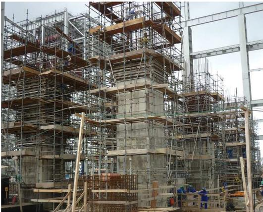
**Foto 3:** Execução da forma dos pilares C8 e C7 do segundo nível.
