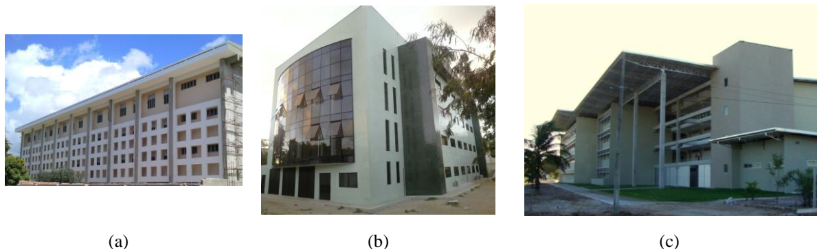
Figura 2 - Fotos dos edifícios selecionados para o estudo: Bloco I do Setor de Aulas IV (a), NUPRAR (b) e Escola de Ciências e Tecnologia (c).
