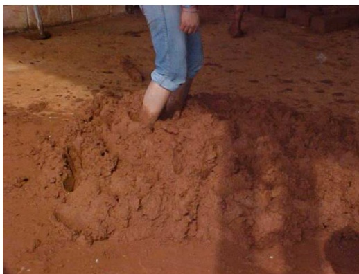
Figura 1: Sequência da Produção de tijolos adobe para moradia do Assentamento Rural Pirituba II (HABIS, 2004).
