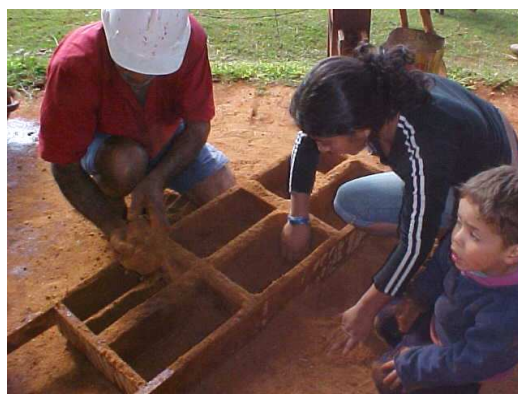
Figura 1: Sequência da Produção de tijolos adobe para moradia do Assentamento Rural Pirituba II (HABIS, 2004).
