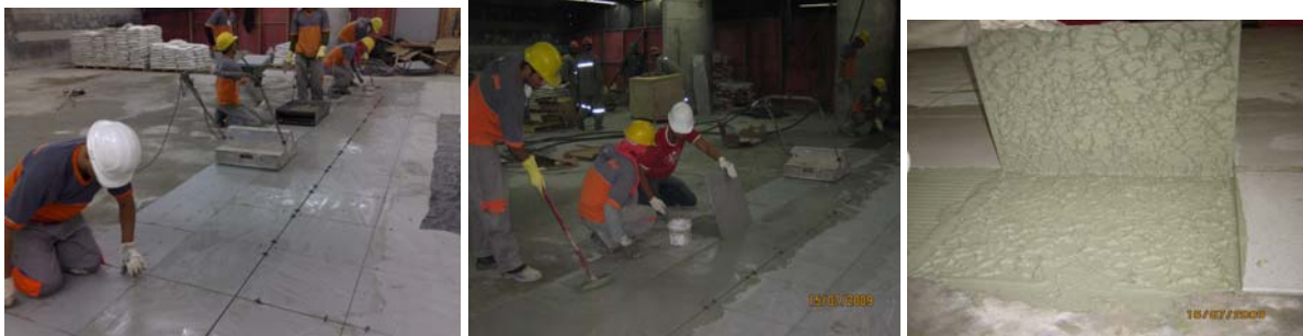
Figura 3 - (a) início aplicação revestimento cerâmico; (b) seqüência de trabalho em grupo com os equipamentos; (c) conferência da aderência da peça cerâmica.
